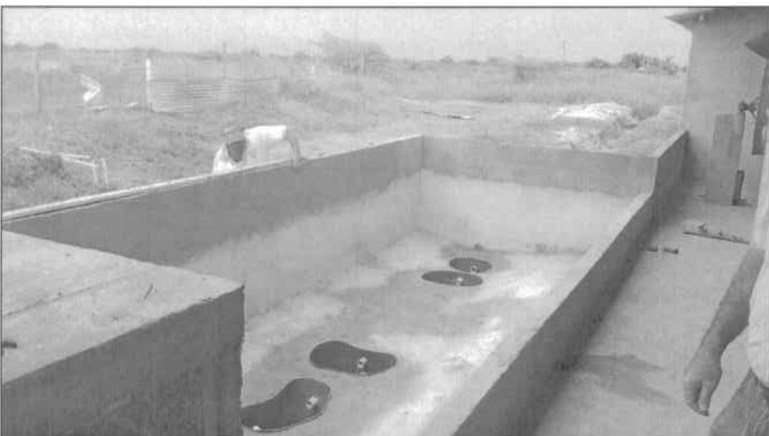
Fotografía No. 2. Imagen del área proyectada para la curtiembre.
