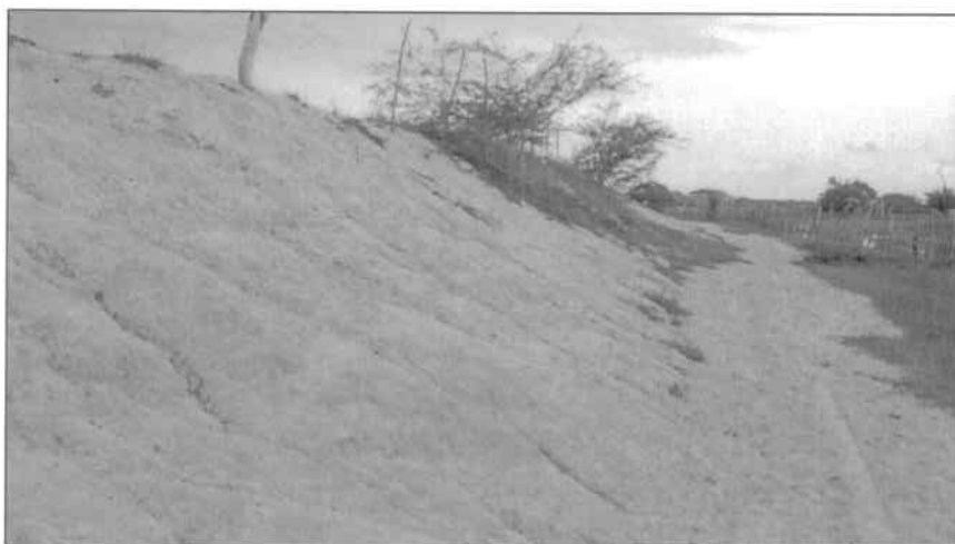
Fotografía No. 4. Imagen del talud reforzado.
